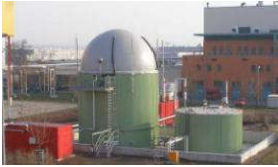
德国Erfurt剩余垃圾渗滤液发酵 (250 kW e1)
