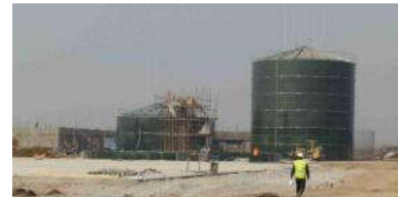
BGA Moo2, China (7000 m³/d Biogas)
