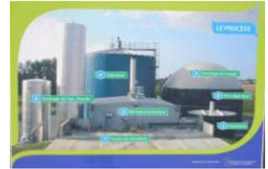
BGA Biogasy1 (F) 615kW e1)
