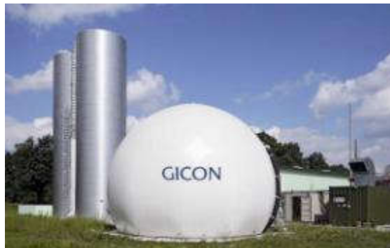
BGA Schöllnitz (250 kW e1)
