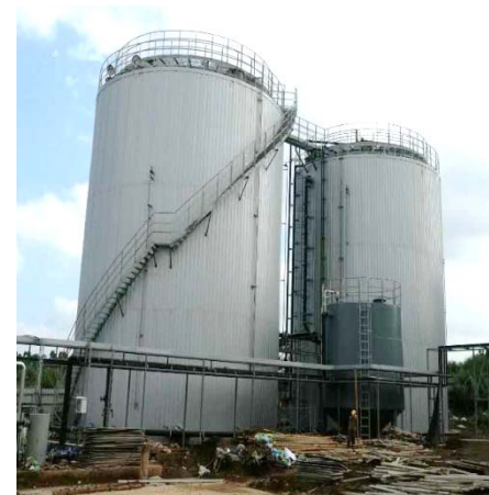
渗滤液发酵罐
