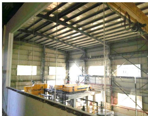
餐厨预处理车间内景
