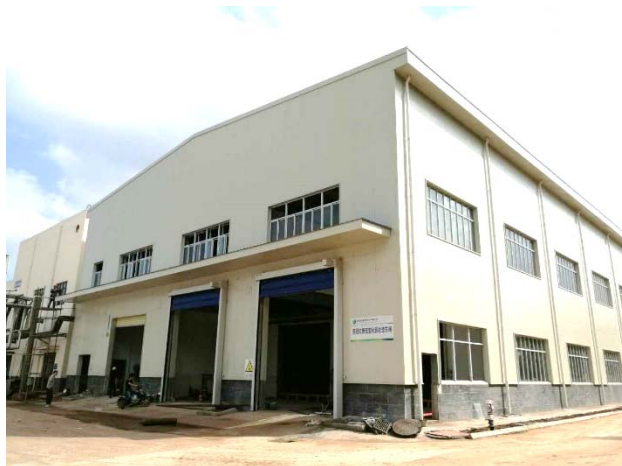
餐厨预处理车间外景
