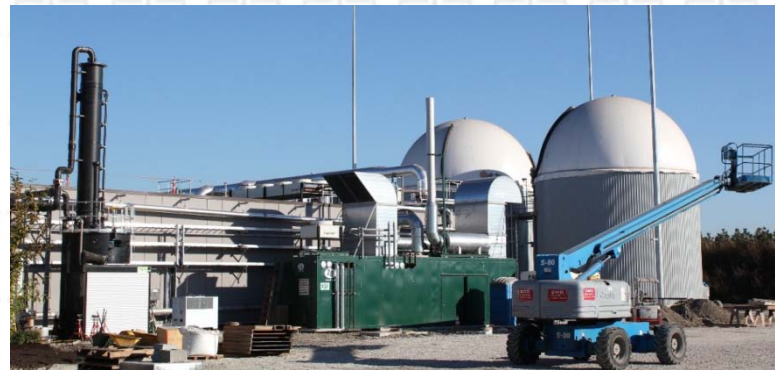
厂区外景 Fermentation Plant
